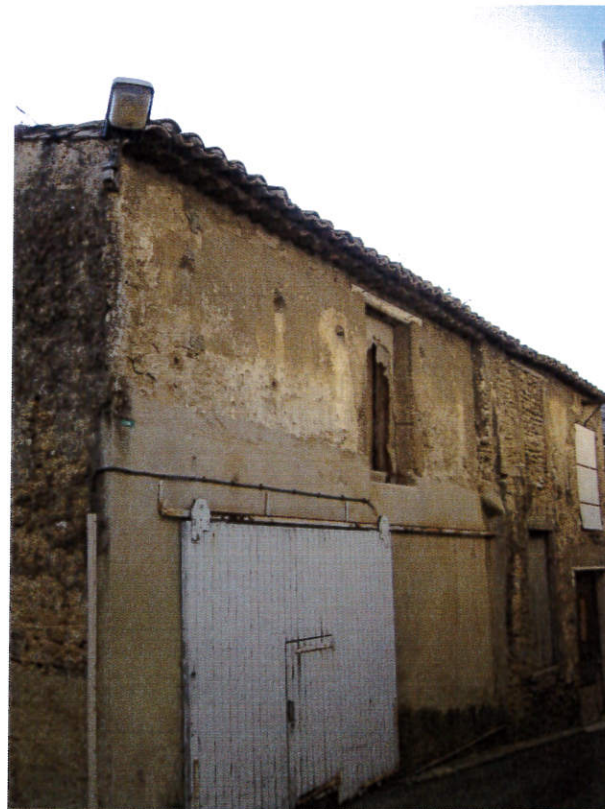
Photo 2 : Vue angle rue du Sommelier et Rue du réservoir
