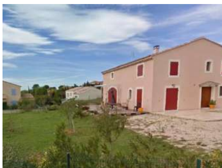
Nouvelle construction chemin des Garrigues
