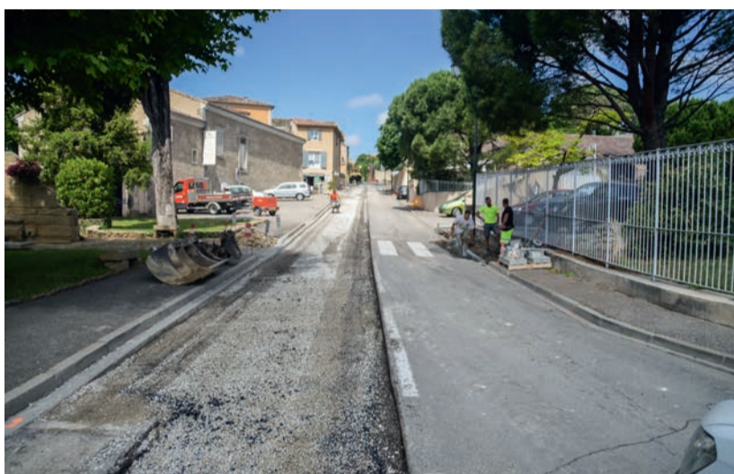
Réfection de la Chaussée Avenue Baron Leroy
