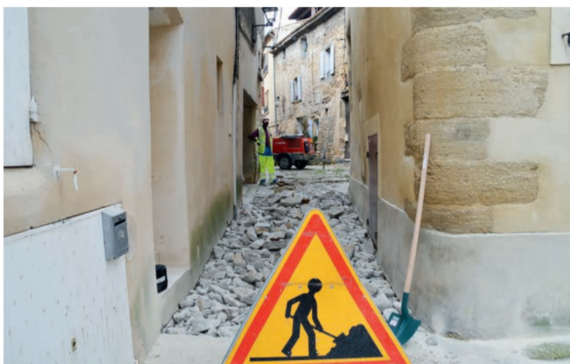
Réfection du revêtement Impasse Mistral
