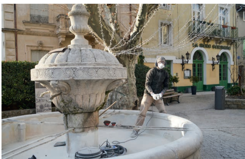
Reprise de l'étanchéité de la Fontaine
