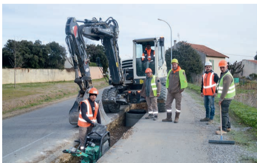
Extension du réseau Route de Sorgues
