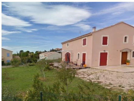
Nouvelle construction chemin des Garrigues
