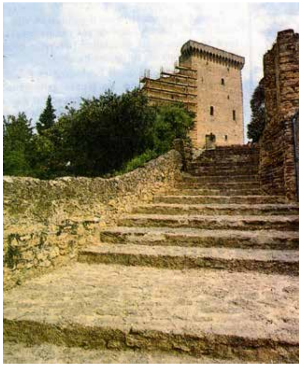
Réfection du mur Est
