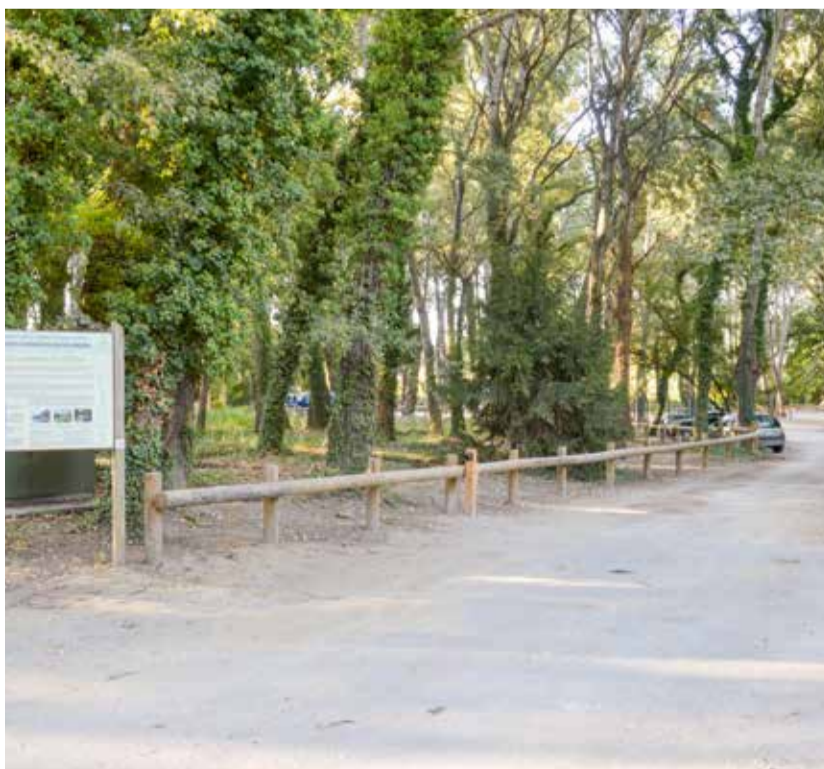
Installation de barrières à l'Isilon St Luc
