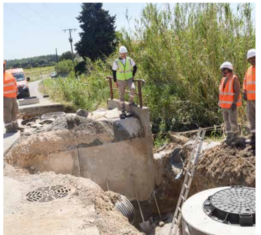
Dévoisement du réseau d'assainissement Bois de Ville
