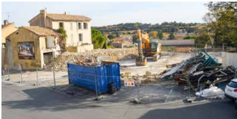
Phase II : Démolition
