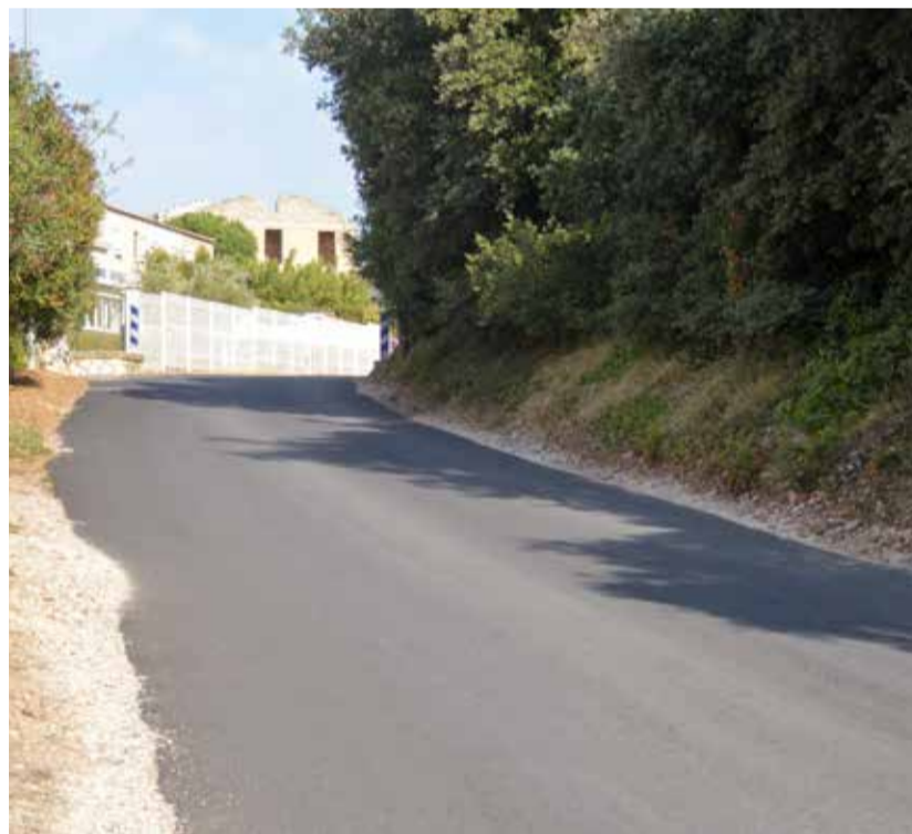
Réfection de la chaussée et pose d'enrobé, Chemin de Boursan
