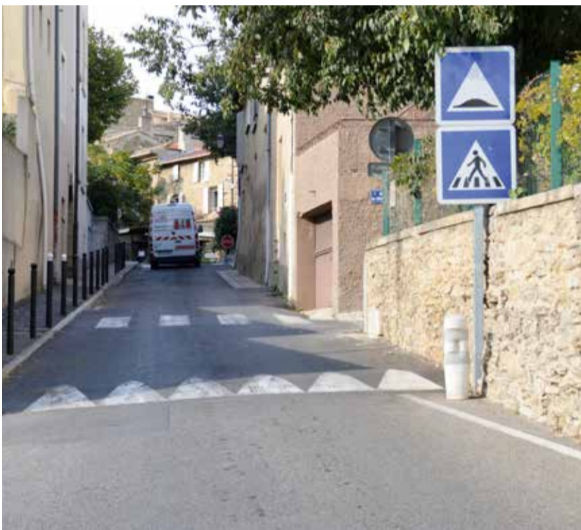
Pose de ralentisseurs Chemin de la Calade, afin de sécuriser le passage piéton, particulièrement emprunté par les familles et les enfants.
